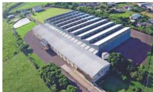
Unidade Santo Antônio da Patrulha - RS - Brasil 7.000m 2 área construída, 30.000m 2 área total
