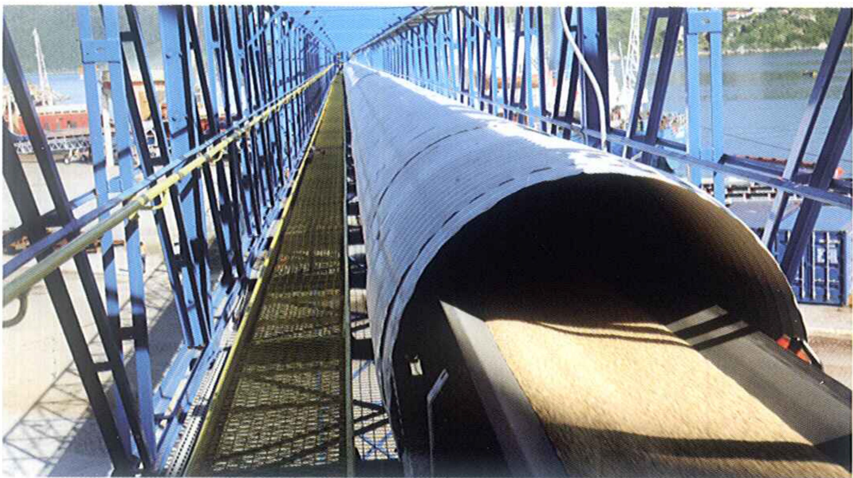
Transportador de correia em passarela metálica
