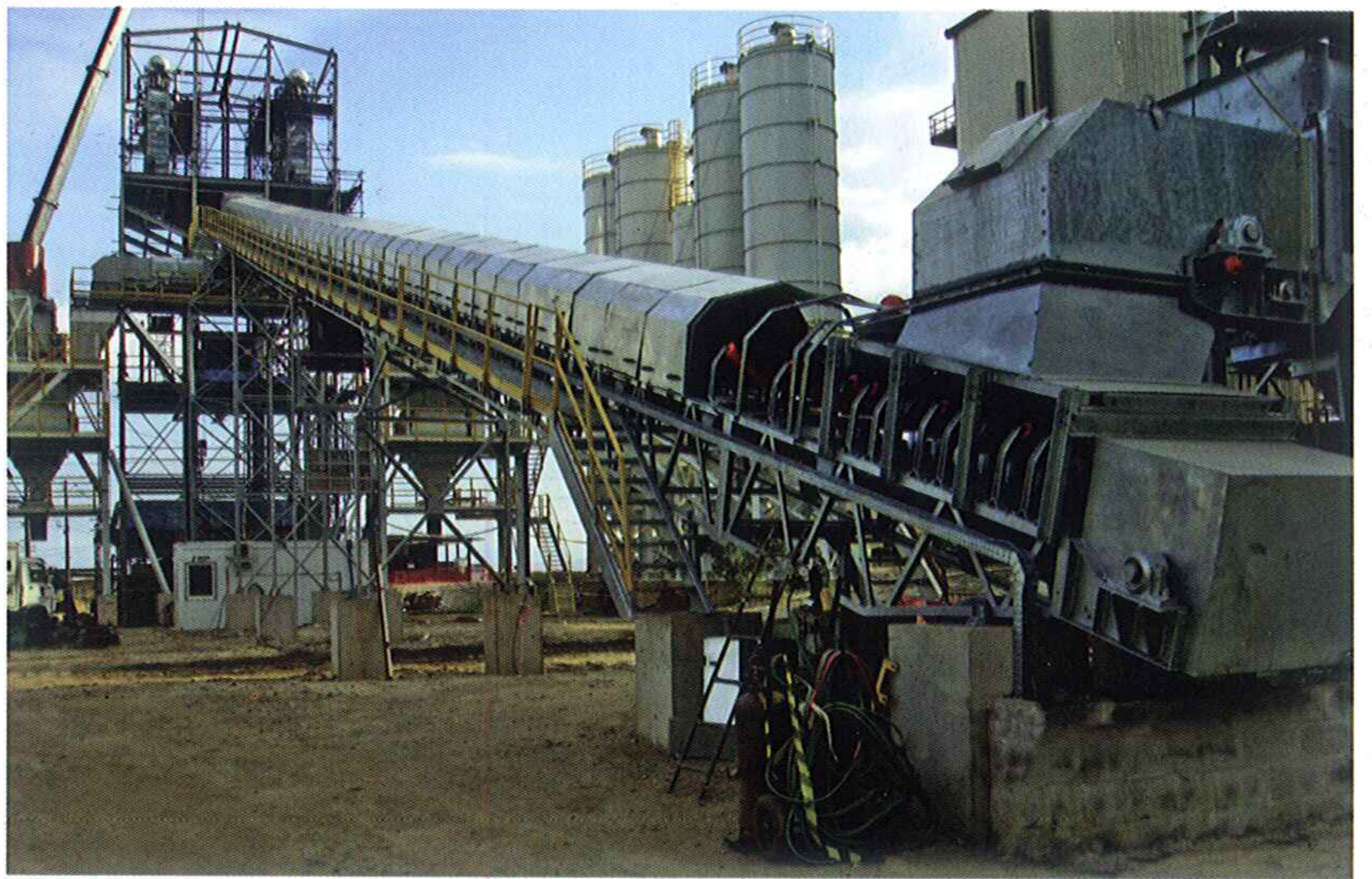
Transportador de correia com cobertura
